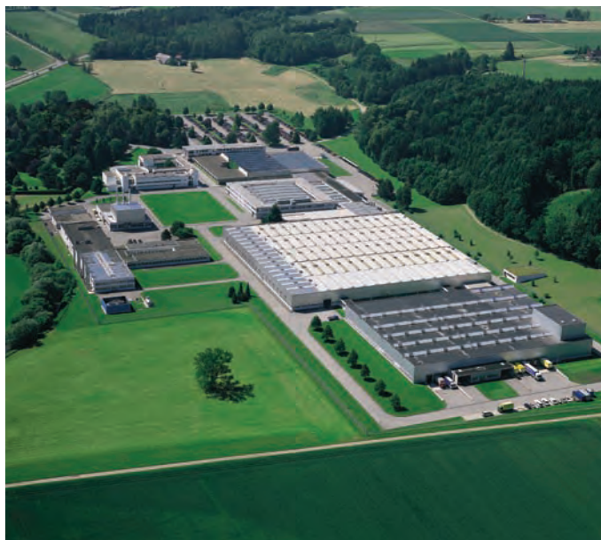
Завод Weishaupt, г. Швенди, Германия
