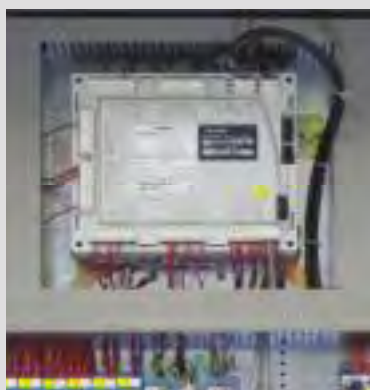
Установка в шкафу управления
