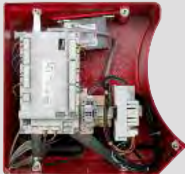
Менеджер горения W-FM54 в корпусе горелки
